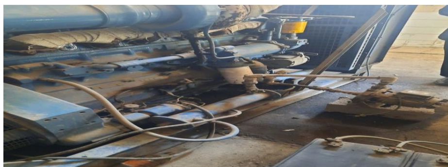
شکل ۱: یک نمونه از آلودگی اجزای مختلف دیزل ژنراتور
