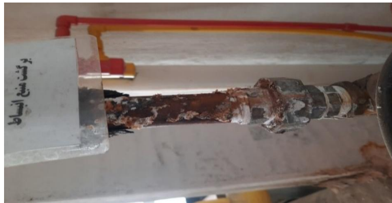
شکل ۴: نمونه وضعیت سولفات شده شدن لوله و اتصالات در پایگاه کرج
