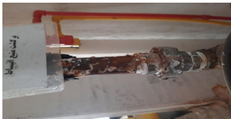
شکل ۴: نمونه وضعیت سولفاته شدن لوله و اتصالات در پایگاه کرج
