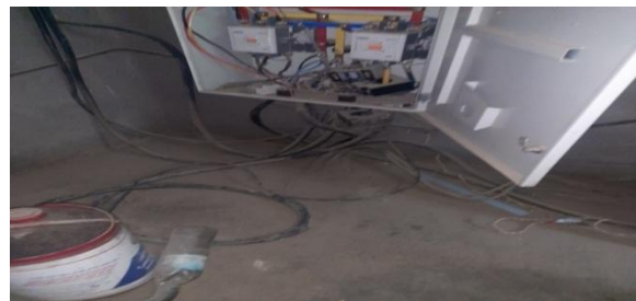
شکل ۱: الف) یک نمونه از نحوه اتصال کابل ها ب) یک نمونه از نحوه تجمع و عبور کابل ها
