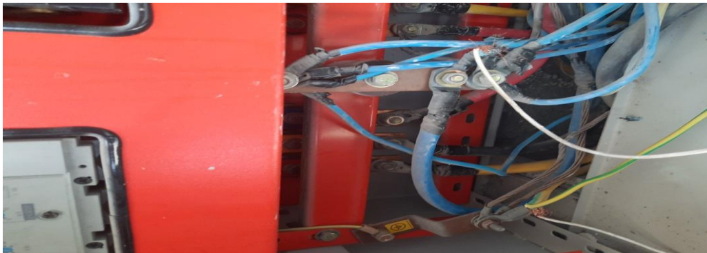
شکل ۳: یک نمونه از اتصال سیم سیستم ارتینگ
