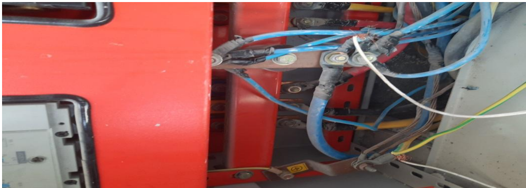
شکل ۳: یک نمونه از اتصال سیم سیستم ارتینگ
