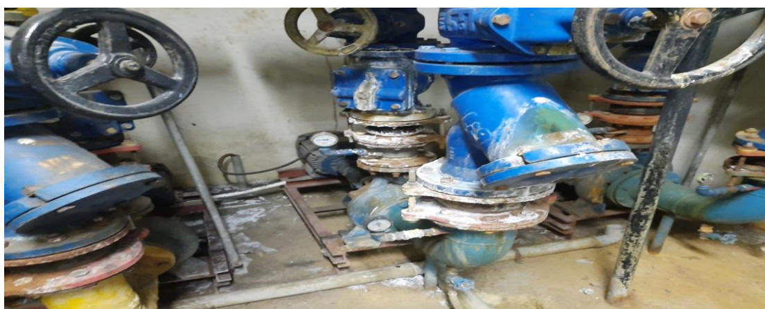
شکل ۱: وضعیت نظافت اجزای موتورخانه در پایگاه سمنان
